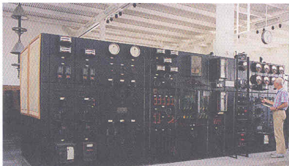
Interiörer från stationen. Ovan Alexandersons alternator. Nedan omkopplarpanelen.
