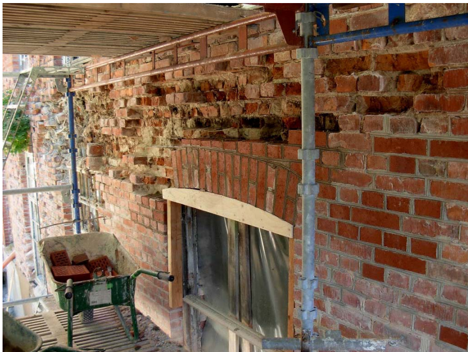
Murverksrestaurering vid Fengersfors bruk. Foto: Bosse Lagerqvist
