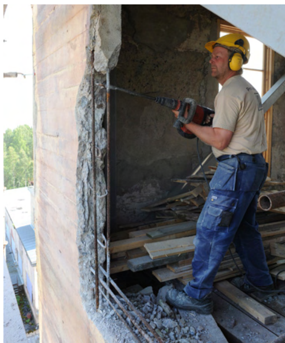
Betongreparationerna på främst laven har varit omfattande och i flera avseenden unika i sitt slag i Sverige. Vissa partier av laven var så dåliga att all betong behövde bilas bort och ersättas med ny.
